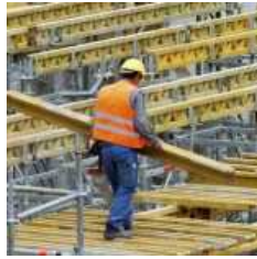
Troika startet letzten Kontrollbesuch in Spanien Bauarbeiten
